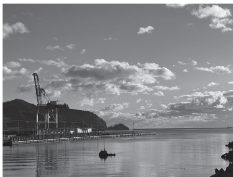
釜石港のガントリークレーン
