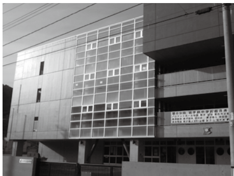
新たに浸水区域に入った釜石中学校
