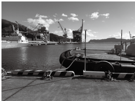
棧橋付近から釜石湾内(湾口防波堤)を望む
