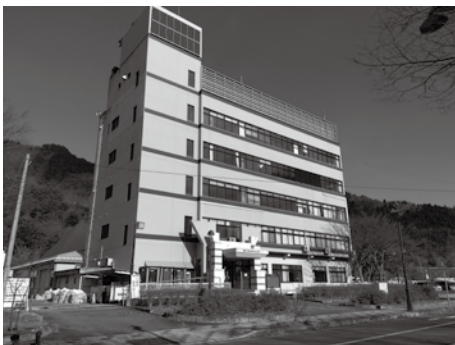
改修工事が進む教育センター
