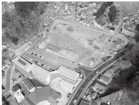
新庁舎建設予定地
