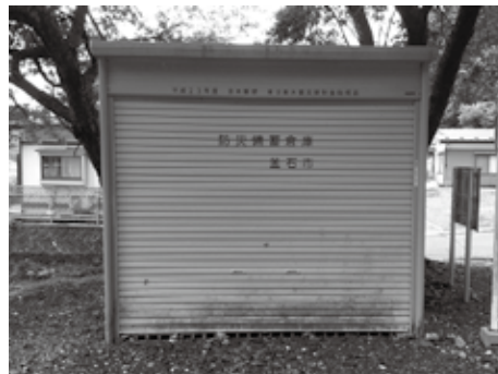
高台に設置された備蓄倉庫
