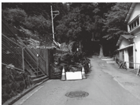
浜町三丁目のがけ崩れ
