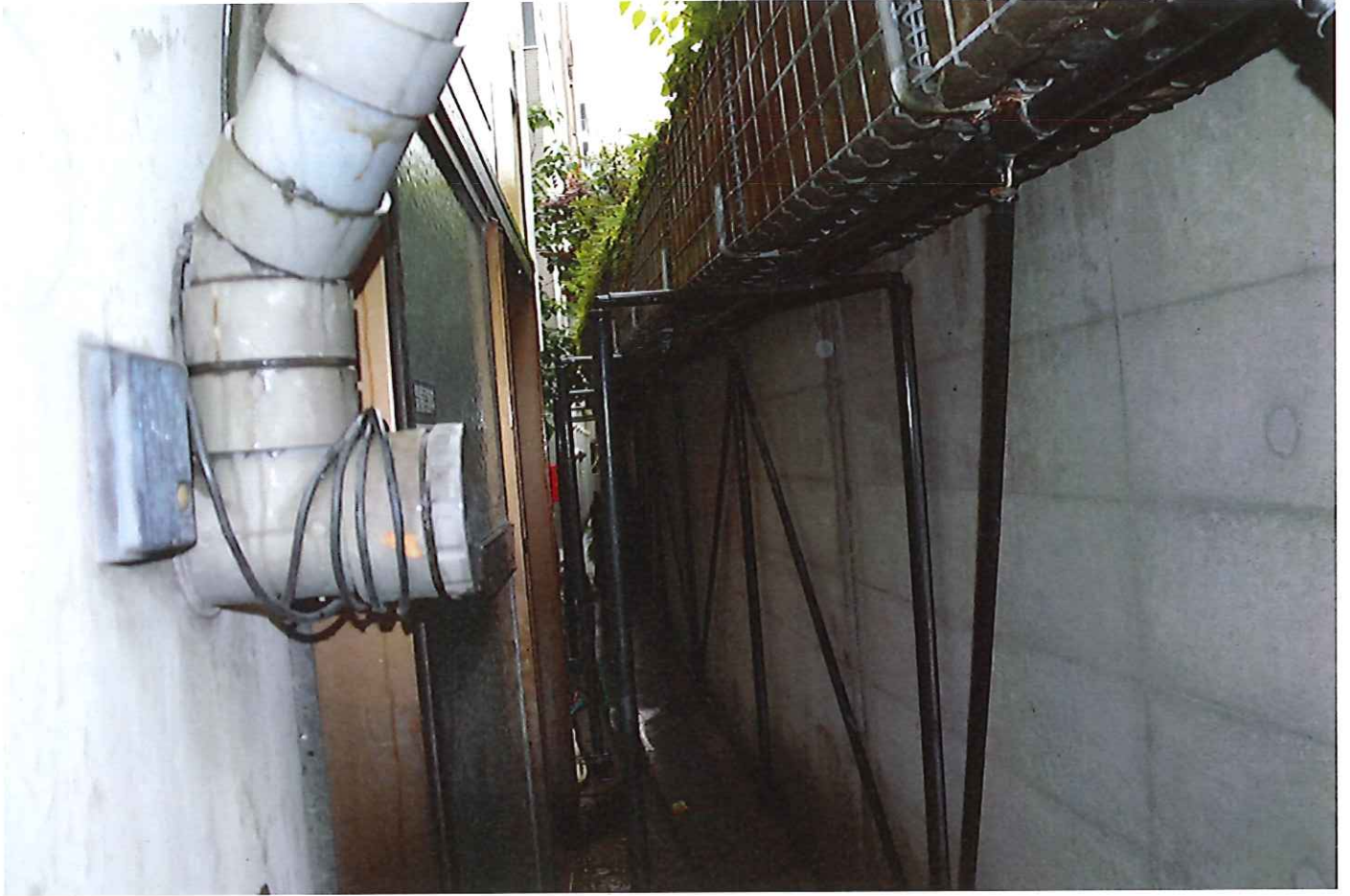
日本橋川護岸緑化 内側
