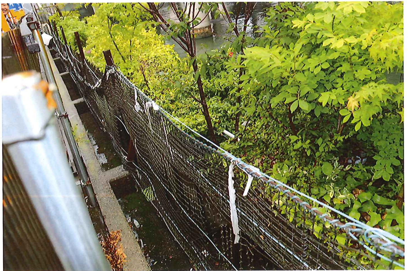
日本橋川護岸緑化 内側
