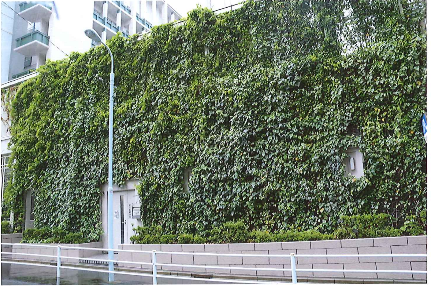
日本橋小学校 壁面一部
