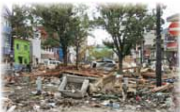
東日本大震災直後の釜石市大町付近 (2011年)
