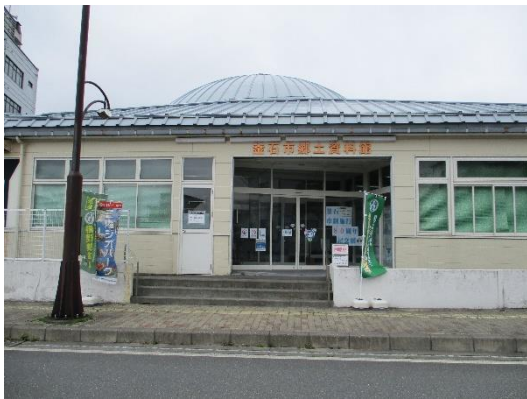
写真 72 釜石市郷土資料館
