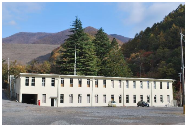
写真 74 旧釜石鉱山事務所
