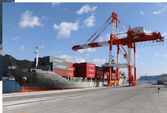
写真 8 ガントリークレーン
