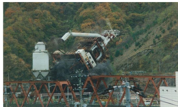
写真 37 製鉄所の高炉解体
