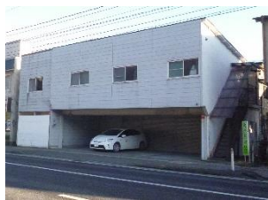
国道側からの外観
