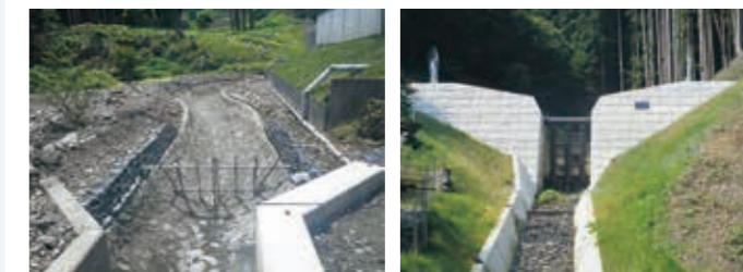
流木・土砂止め工
