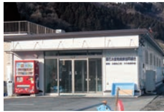
釜石水産物商業協同組合 (浜町 平成28年4月稼働開始)
