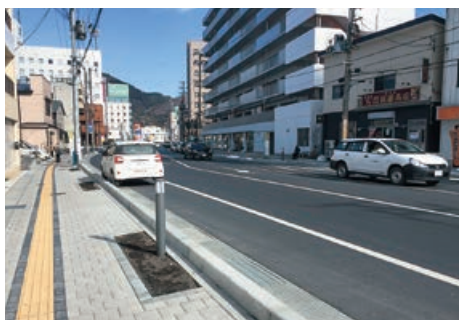
（中心市街地東部地区の復興状況）
