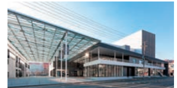
釜石市民ホール
