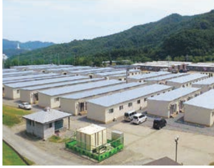
平成23年8月10日(水) 平田第6仮設団地、41棟・240戸を設置
