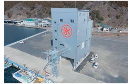
新浜町地区に整備の製氷貯水給水施設 (平成29年4月稼働開始) (整備主体:釜石市漁業協同組合連合会)
