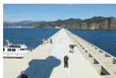
3月に報道機関向けに公開された北堤
