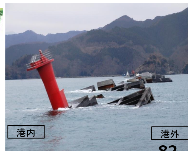
(撮影) 北堤の倒壊状況
