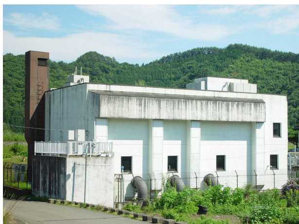
鵜住居雨水排水ポンプ場
