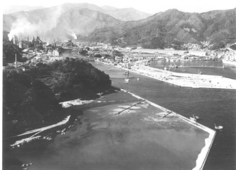
昭和45年、処理場用地を含む大平工業団地の埋立工事中のようす (釜石市郷土資料館蔵、撮影:丹野雅史氏)
